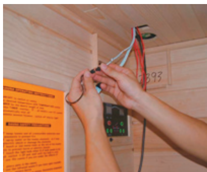
Verkabelung Temperaturfühler
